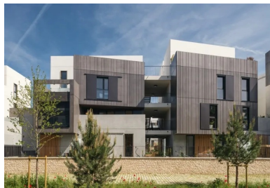
Les sous-bassements sont en béton brut, les parties en débord sont striées et teintées dans la masse, et les acrotères en béton blanc.
