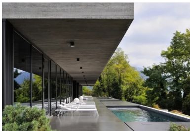
Le porte-à-faux de 3 x 40 m de longueur vient comme un auvent protéger la terrasse
