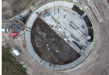
Les radiers des deux bassins, épais de 66 cm, ont été coulés en fond de fouille avec un béton mis en œuvre par pompage.
