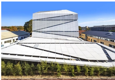
Inscrit au cœur du campus, le nouveau bâtiment universitaire déploie le design inédit de sa vêtue en panneaux de bFUP.
