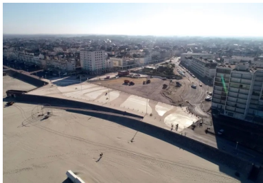
Une première phase de requalification concerne 17 000 m². Quelque 3 200 m³ de béton ont été mis en œuvre par Eurovia, soit 400 toupies de 8 m³.
