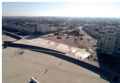
Une première phase de requalification concerne 17 000 m 2 . Quelque 3 200 m 3 de béton ont été mis en œuvre par Eurovia, soit 400 toupies de 8 m 3 .
