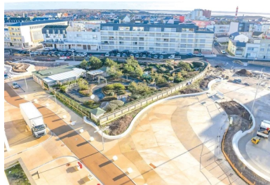
La couleur de base du béton est celle du sable de Berck. Selon le projet de Paysage 360, cette teinte se décline ensuite - du plus sombre au plus clair pour reconstituer les méandres de l'ancienne rivière.
