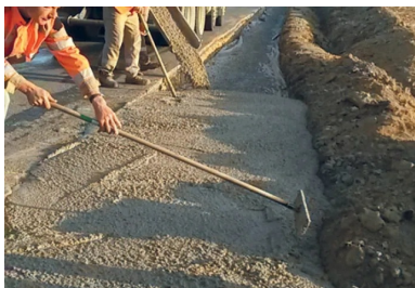
Les premières poutres Maces (40 cm d'épaisseur) ont été réalisées à compter de début septembre 2018. La mise en œuvre s'est effectuée par simple versement dans la fouille depuis les toupies, suivi d'un traitement manuel léger et d'une finition au râteau.
