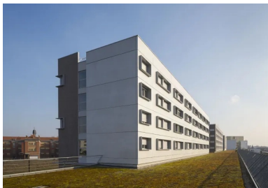
La texture peu marquée recouverte d'une lasure blanche met en valeur la géométrie des panneaux et des ouvertures dans la composition de la façade sud de la résidence pour étudiants dessinée par Dominique Tirard.
