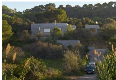
Les différents volumes en béton à la planche composant la maison s'intègrent harmonieusement dans le grand paysage.
