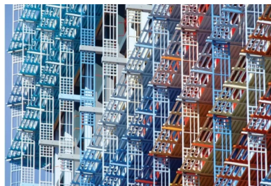
Tout en dentelle et couleurs, la grille en Bfup des façades sud et ouest semble particulièrement légère.
