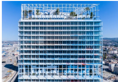
Façade sud. Par leur prolongement sur les faux plafonds, les couleurs des brise-soleil estompent la limite entre intérieur et extérieur.
