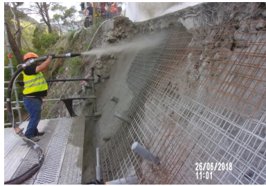
Confortement de talus par voie sèche.
