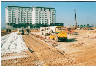
Chantier de traitement de sols pour une plate-forme industrielle
