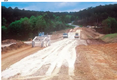
Chantier de traitement de sols en terrassements routiers
