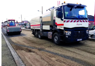
Au premier plan, un PATA (point à temps automatique, épandeur de liant et gravillonneur sur le même châssis) suivi d'un atelier de compactage.
