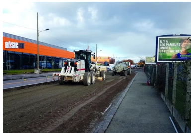
Réglage après malaxage, selon le profil déterminé. Devant la niveleuse, une citerne a pour fonction de maintenir la teneur en eau du mélange.
