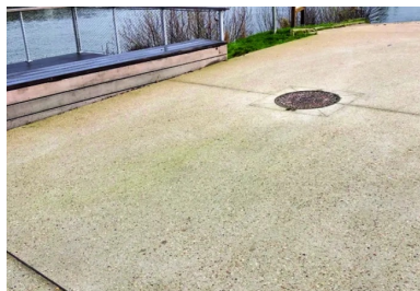
Le cheminement s'ouvre régulièrement, côté fluvial, sur des aménagements - façon belvédères - avec points de vue avancés sur la Seine (en arrière-plan). Au premier plan et en médaillon, un joint de dilatation.
