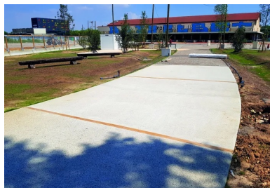
En juin 2018, les premières planches d'essais sont coulées à l'entrée du parc de la Station Mue. « Nous avons commencé par faire de petites planches, puis, de fil en aiguille, des planches de plus en plus grandes, poursuit Nicolas Brasier (Vicat). Finalement, nous avons atteint les objectifs : créer un nouveau béton à partir de rebuts de béton. »
