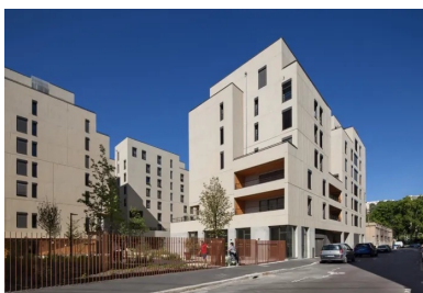
Dense et poreux, l'îlot est composé d'immeubles alignés sur rue.
