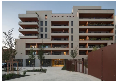
La combinaison du béton matricé, des éléments de serrurerie et du végétal structure l'opération.
