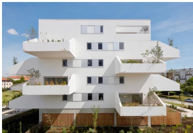
Les huit volumes de l'opération jouent sur la discontinuité et ouvrent le nouveau quartier sur la ville.
