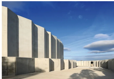
On accède à la grotte latéralement, par une descente en rampe, accompagné par des parois béton de panneaux préfabriqués à coffrage intégré.
