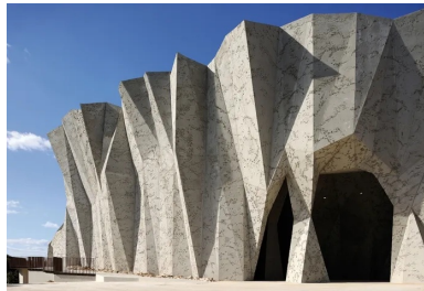
Du nord au sud, le bâtiment passe du lisse du béton préfabriqué à la rugosité du béton projeté et soufflé.
