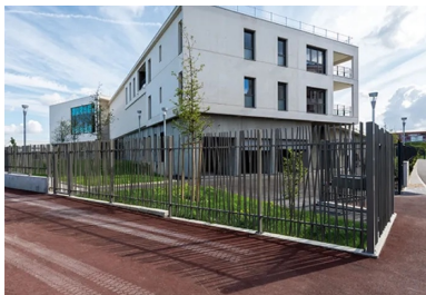
Le système structurel associe planchers, murs de refends intérieurs et façades porteuses coulées en place en béton blanc autoplaçant.
