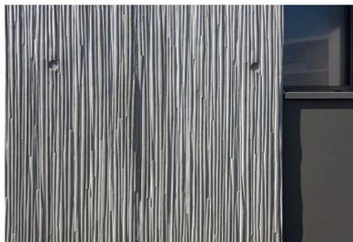
L'effet de socle du rez-de-chaussée est renforcé par l'utilisation d'un béton matricé gris clair autoplaçant coulé dans des moules à relief.
