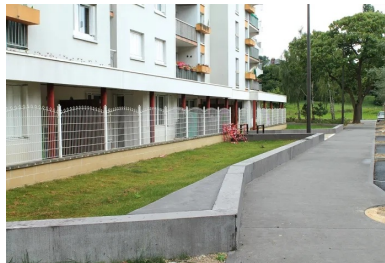
Le quartier maison Rouge dispose désormais de trottoirs en béton chocolat sablé avec liseré lisse. Les murets également en béton chocolat ont, quant à eux, une finition brossée.
