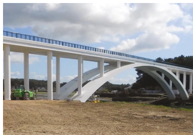
Pont Kerisper après travaux
