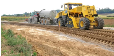
Derrière le malaxeur Bomag RS 650, un technicien vérifie visuellement l'homogénéité du mélange entre le matériau de l'ancienne chaussée et le liant hydraulique, et un autre mesure la teneur en eau du matériau traité.
