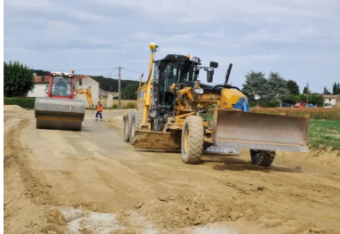
Derrière le malaxeur, la mise en œuvre se poursuit avec le nivellement de la chaussée (à droite) et le compactage du matériau (à gauche).
