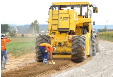
Derrière le malaxeur Bomag RS 650, un technicien vérifie visuellement l'homogénéité du mélange entre le matériau de l'ancienne chaussée et le liant hydraulique, et un autre mesure la teneur en eau du matériau traité.
