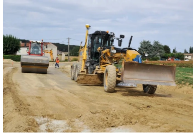
Derrière le malaxeur, la mise en œuvre se poursuit avec le nivellement de la chaussée (à droite) et le compactage du matériau (à gauche).
