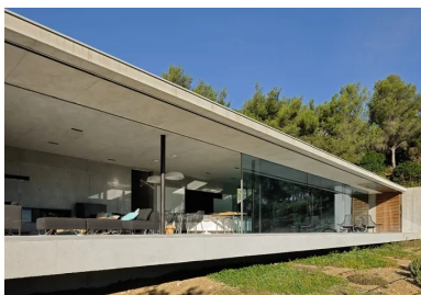
Le volume inférieur prend la forme d'un parallépipède rectangle allongé en béton brut, dont la longue façade entièrement vitrée offre une vue panoramique sur la mer
