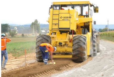
Et un autre mesure la teneur en eau du matériau traité.
