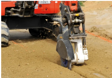
Le groupement E26-Guintoli a mis en œuvre deux systèmes de sciage, dont une dent crantée montée sur une pelle, intervenant systématiquement tous les quatre mètres pour canaliser les éventuelles fissures transversales...
