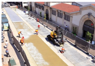
Du premier plan à l'arrière-plan, les différentes étapes du chantier : lissage, pulvérisation du produit de cure, déploiement du géotextile.
