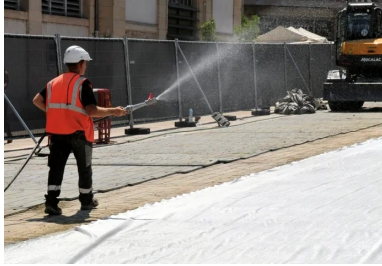
Un géotextile est déployé pour protéger la nouvelle chaussée. But - renforcer encore la prise du béton. Il sera arrosé toutes les heures jusqu'au soir.
