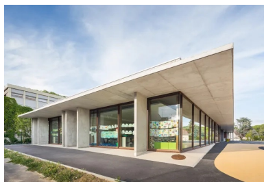
L'avent de la façade ouest repose en partie sur des voiles béton verticaux qui complètent le dispositif brise-soleil.
