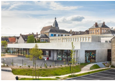
Les acrotères en béton texturé donnent une épaisseur à la toiture et une assise à l'édifice.
