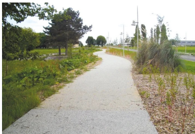
Produit dans l'unité Cemex de Giberville, le béton décoratif mis en œuvre sur les cheminements du nouveau quartier Kœnig est un béton C25/30 XF2 fibré (formule Nuantis Minéral de Cemex, ciment Calcia).
