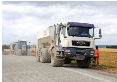
Épandage du liant hydraulique routier LHTS 54 de Vicat et vérification de la bonne répartition du liant au mètre carré (méthode dite « à la bêche »).
