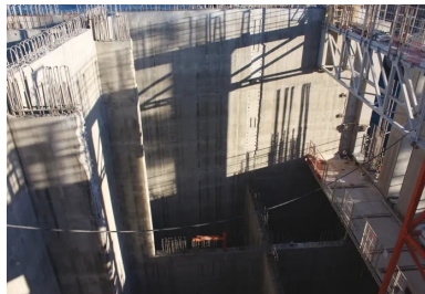
Vue de la future chambre Jarlan, dont la fonction est d'atténuer l'énergie des vagues.
