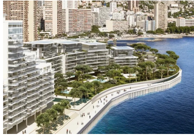
Les programmes de l'extension (logements de très grand luxe, commerces...) seront fondés sur un remblai de sable marin. La face supérieure de la ceinture de caissons accueillera une promenade piétonnière.
