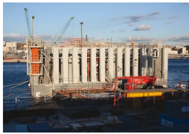
Afin d'éclaircir la teinte des poteaux Jarlan en béton qui resteront visibles en phase définitive, leur formulation intègre du dioxyde de titane.
