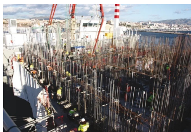
Le coulage de chaque caisson dans un coffrage glissant intégral est réalisé en continu 24 h/24 et 7 j/7. L'élévation moyenne est fixée à 12 cm/h.
