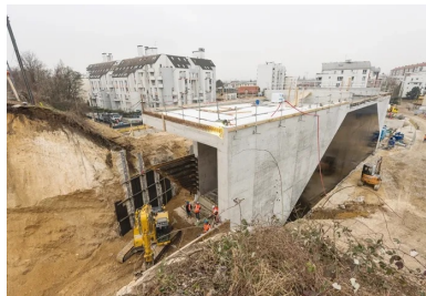
Ripage du pont-rail à Champigny.
