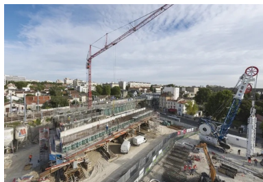
Réalisation du pont-dalle.
