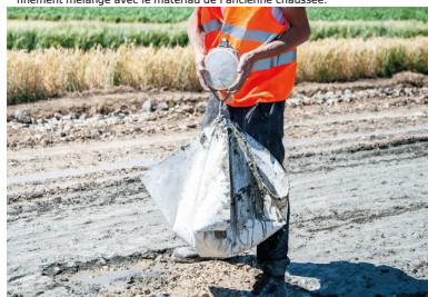
ontrôle de la régularité de l'épandage et de la quantité des liants réalisés par la méthode dite « à la bêche ».
