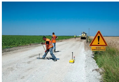
À droite, contrôle de la régularité de l'épandage et de la quantité des liants réalisés par la méthode dite « à la bêche ». À gauche, préparation d'un test de compacité. En médaillon, résultat à l'issue du malaxage : le liant clair a été finement mélangé avec le matériau de l'ancienne chaussée.
