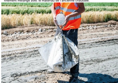
Contrôle de la régularité de l'épandage et de la quantité des liants réalisés par la méthode dite « à la bêche ».
