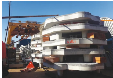
Dalles Rague en béton bicouche de Seabost, sur le quai, avant leur mise à l'eau dans la calanque de Cortiou.
