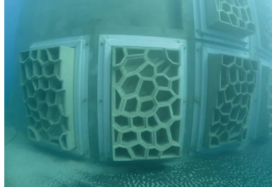
À la Réunion, les casiers Panal® réalisés en CCV, insérés dans des cadres en acier inox et scellés sur les piles du viaduc de la route du Littoral.
