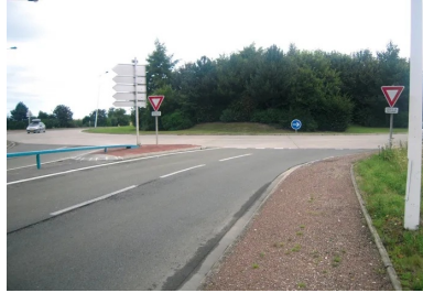
Carrefour giratoire Euro Chanel à Neuville-Lès-Dieppe (RD925). Structure BC5g sur couche de forme, réalisée en 1995.
