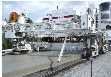
Chaussée composite. Mise en œuvre du béton, à l'aide d'une machine à coffrages glissants, sur une fondation en grave-bitume.
