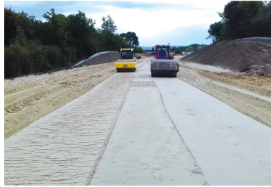
Atelier de compactage de la couche de forme traitée au chanvre et au liant hydraulique routier.
